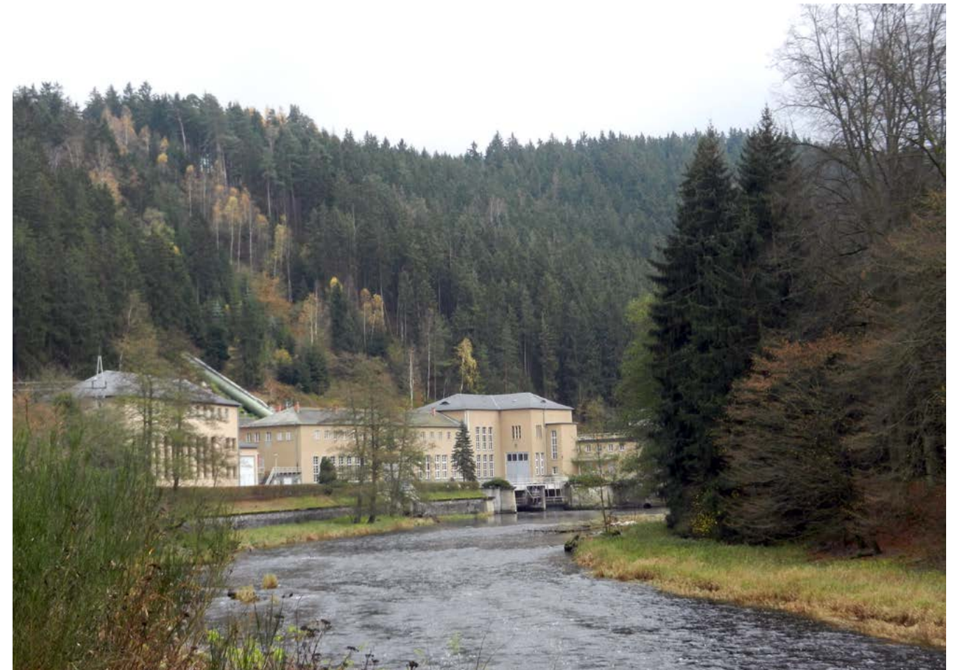
Bild 11: WKA Walsburg-Wisenta (Aufnahme 2014). Im mittleren Gebäude befinden sich die 1920 installierten Turbinen, dahinter ist am Berghang die Druckrohrleitung vom Wisenta-Stausee zu erkennen. Im rechten Gebäudeteil nutzen heute zwei Turbinen das in der Talsperre Walsburg (rechts anschließend) gestaute Wasser der Saale. [31]
