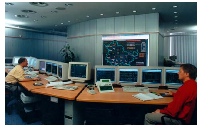
Bild 85: TEAG-Lastverteilung Erfurt mit Spider EMS/ Scada, ABB
