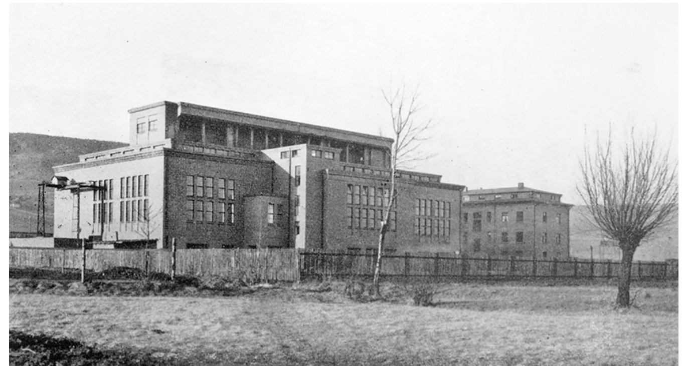
Das 100/50/10-kV-Umspannwerk Jena-Nord
