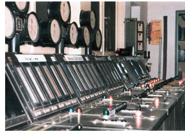
Bild 14: Warte mit Steuerpult und Instrumententafel, UW Jena
