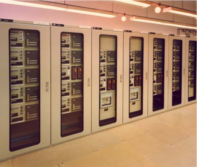
Bild 64: Die ABB-Relaischränke REL316 und RET316 im UW Bleicherode (ENAG)
