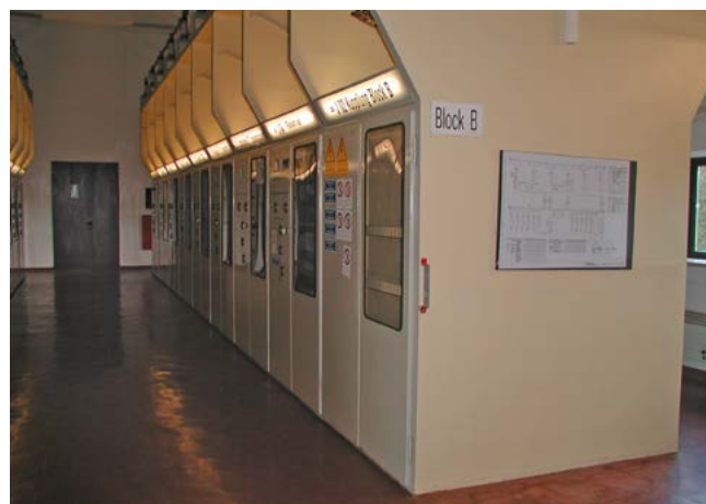
Bild 45: PAB-Bauweise, UW Taubenbach
