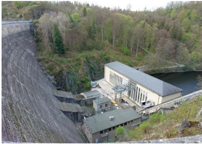
Bleiloch-Staumauer mit Kraftwerk (Foto: M. Wenzel)
