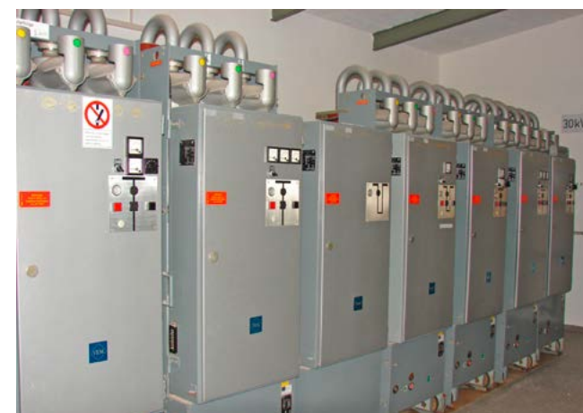
Bild 48: ASIF36, OBSAD, UW Eisenach/West
