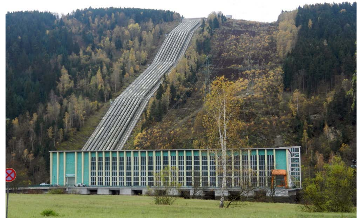
Bild 17: PSW Hohenwarte II mit Krafthaus und Rohrbahn [31]
