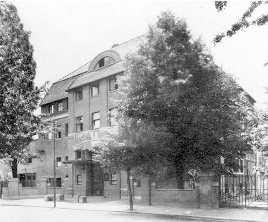
Verwaltungsgebäude des Thüringenwerks in Weimar, Cranachstr. 47
