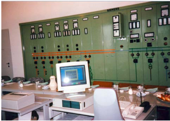
Bild 65: Blindschaltbild und MMK im UW Neuhaus-Schierschnitz
